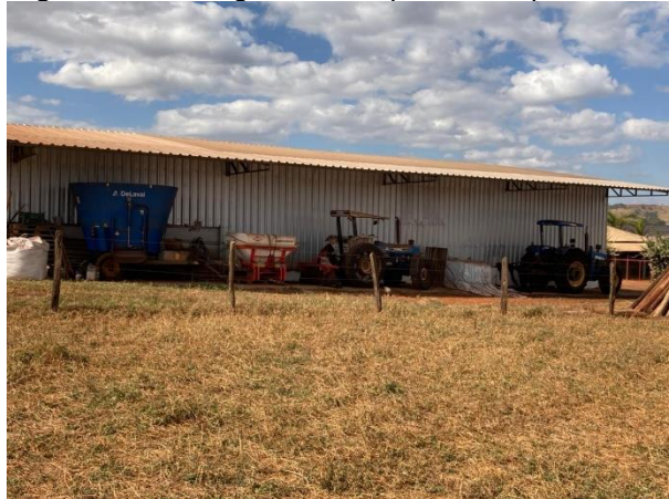
Figura 10: Garragem de máquinas e implementos.
