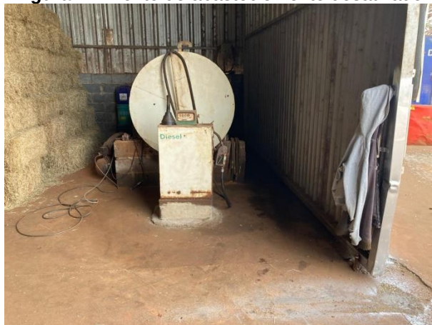
Figura 11: Ponto de abastecimento desativado.
