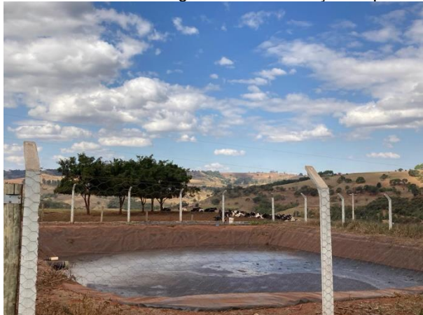
Figura 09: Chorumeira/lagoa de estabilização impermeável.
